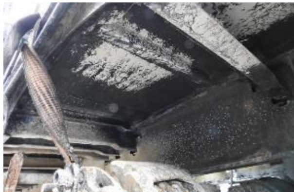
Ft.21 Oplata iznad točka z.osovine-desna strana Opis oštećenja: Nema tragova mehaničkih oštećenja usled trenja pneumatika.
