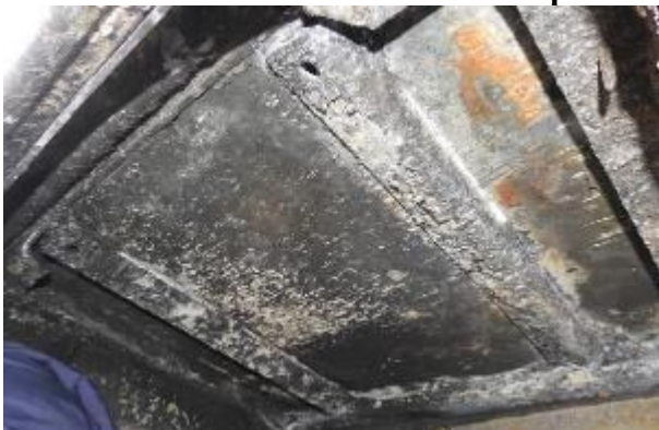
Ft.20 Oplata iznad točka z.osovine-leva strana Opis oštećenja: Nema tragova mehaničkih oštećenja usled trenja pneumatika.
